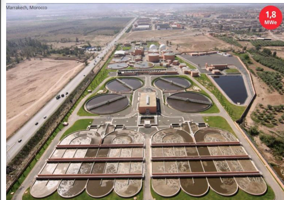
سیستم تجزیه بی‌هوازی خشک پسماندها در کشور مراکش با ظرفیت تولید ۱/۸ MW انرژی و ۱۸۰۰۰ Nm 3 گازهای زیستی در هر روز
